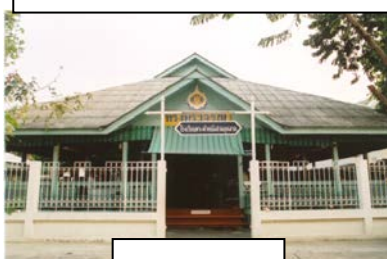
อาคารโรงโขน
